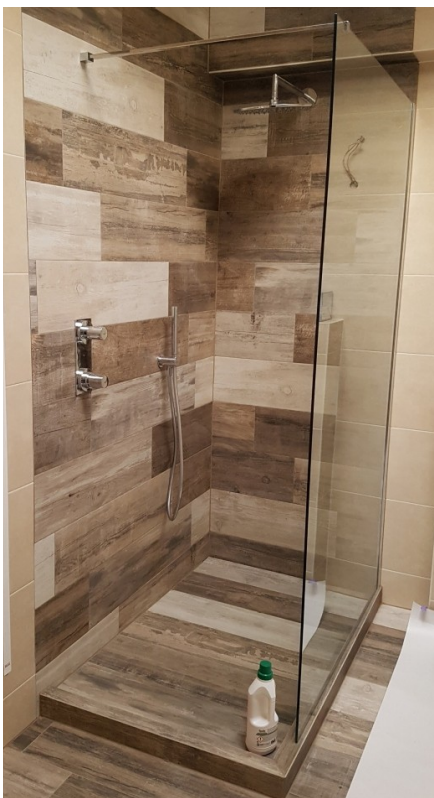
De oranje waterafdichting van Schlüter-Systems wordt helemaal weggewerkt onder de tegels
